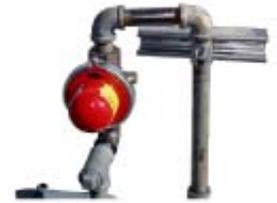
12. Termine de instalar el sistema de tubería del medidor con la válvula sísmica PSP.
