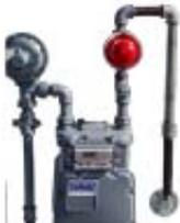
9. Instale la empaquetadura de unión y la nueva tubería desde el medidor hasta el edificio.
