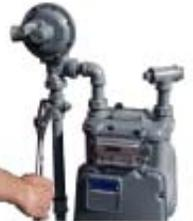
2. Cierre el gas en la válvula de entrada del medidor. No use una llave de tubos.
