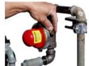
14. Abra el paso de gas en la válvula de entrada del medidor. No use una llave de tubos.
