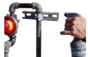
16. Aplique una mano de pintura a toda la tubería nueva para evitar la corrosión.
